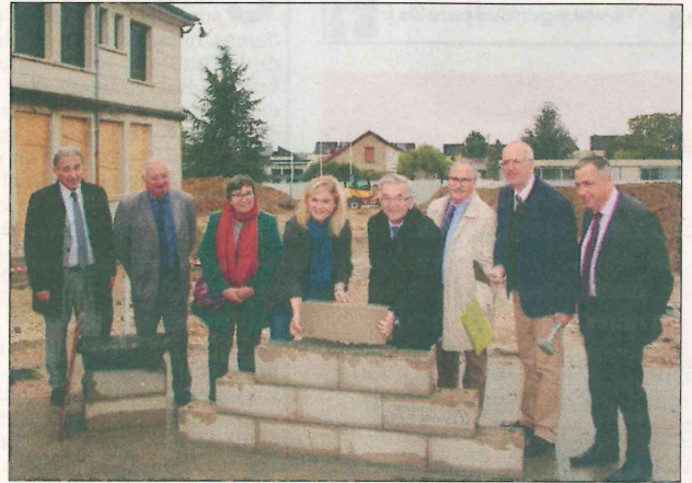
☑ Le président de la Région a symboliquement posé la première pierre des travaux d'extension.
